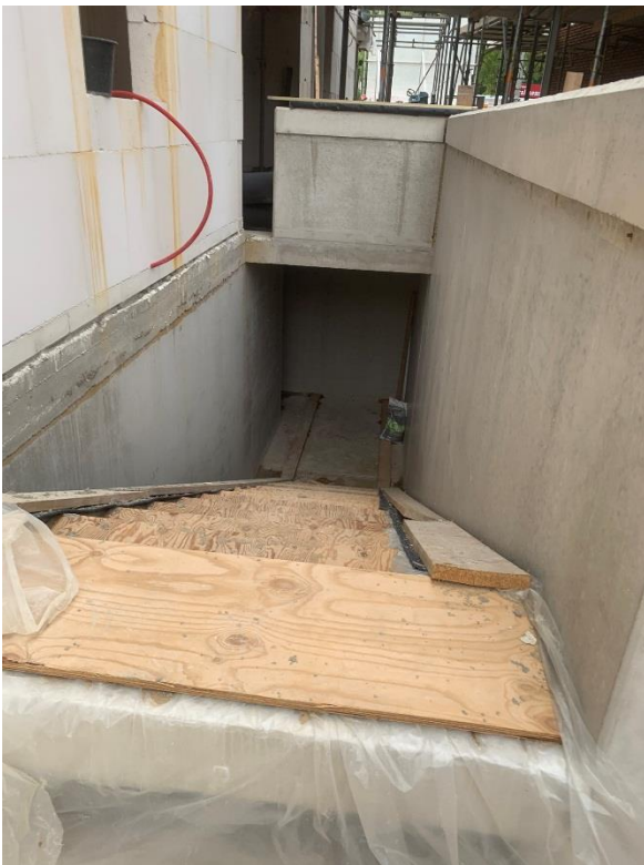
Trap met fietsgoot naar de kelder
