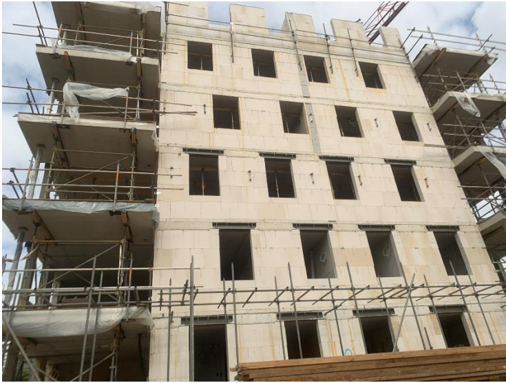
6 e woonlaag in aanbouw
